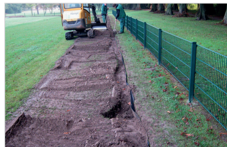
Graben nach Einbau der Noppensperre verfüllen und zur Nachsaat vorbereiten.
