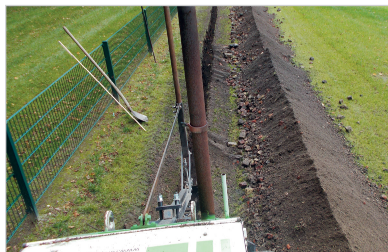
Herstellung des Grabens mit Grabenfräse zum Einbau der Noppensperre.
