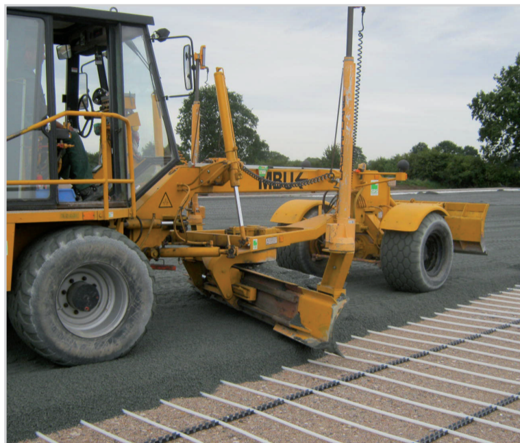
Maschinen im Einsatz.
