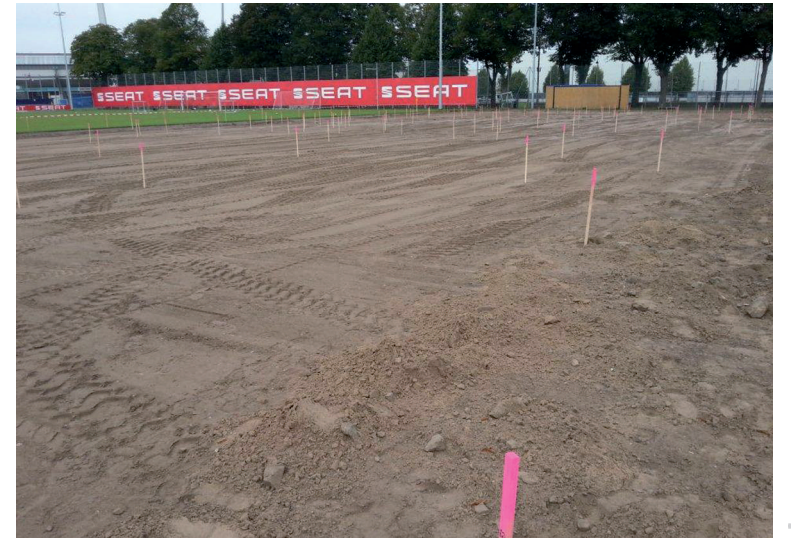
Flächenvorbereitung für Schachtarbeiten
